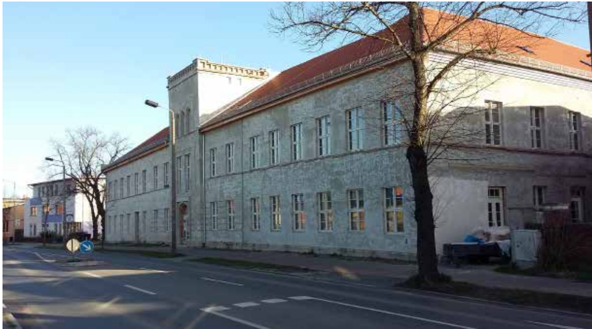
Gesellschaftshaus, Stralsunder Straße 10, Greifswald, Straßenansicht
